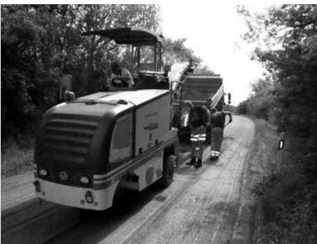
Asphalt-Fräsarbeiten im Ortsgebiet
