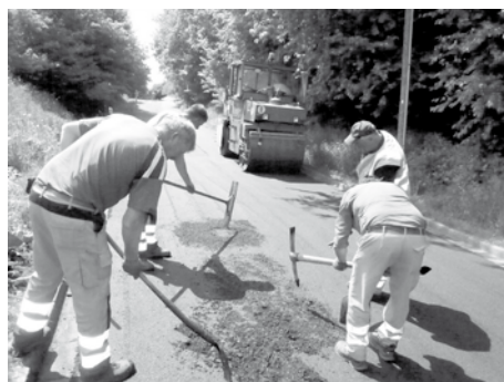
Asphaltarbeiten durch die Mitarbeiter des Bauhofs
