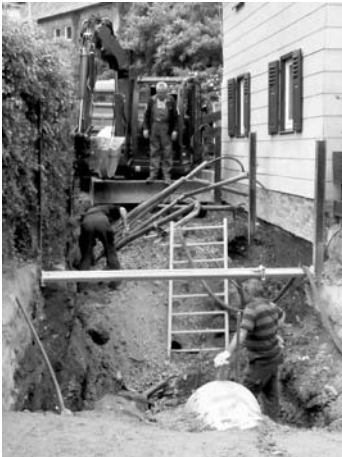
Bauarbeiten Kellergasse Strössendorf
