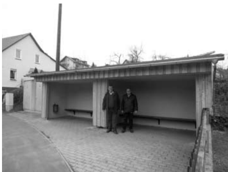
Saniertes Buswartehäuschen in Woffendorf
