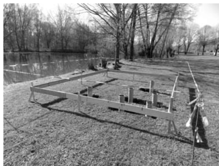
Fundamente für Wasserspielgeräte Spielplatz Schulzentrum
