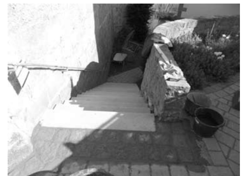
Neue Treppe an der Strössendorfer Kirche
