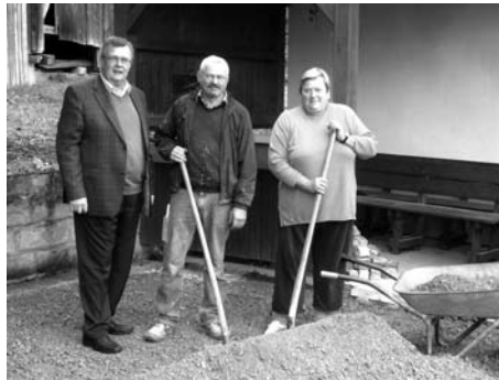
Sanierung des Bodenbelags im Wartehäuschen Spiesberg
