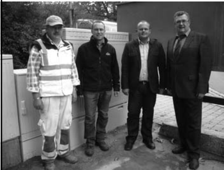
Breitbandinstallation Verteilerkasten in Mainneck
