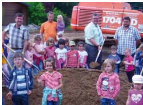
Spatenstich zur Erschließung von 16 Bauplätzen
