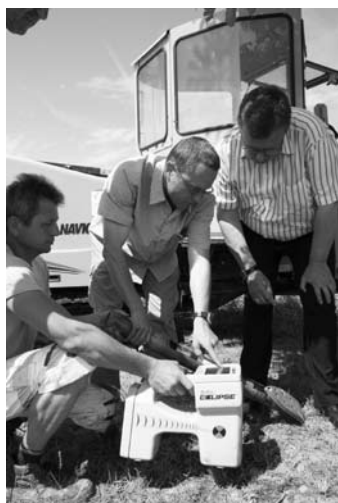
Verlegung neuer Breitbandkabel
