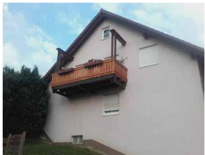
Restaurierter Balkon am gemeindlichen Wohnhaus Schlesierstraße
