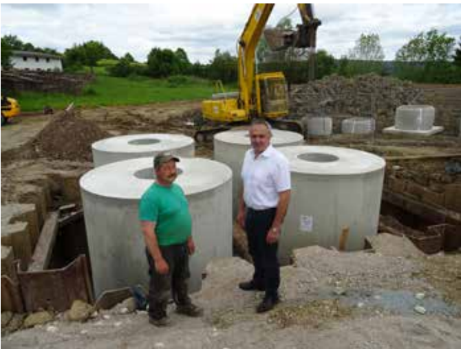
Baustelle Kläranlage Zeublitz
