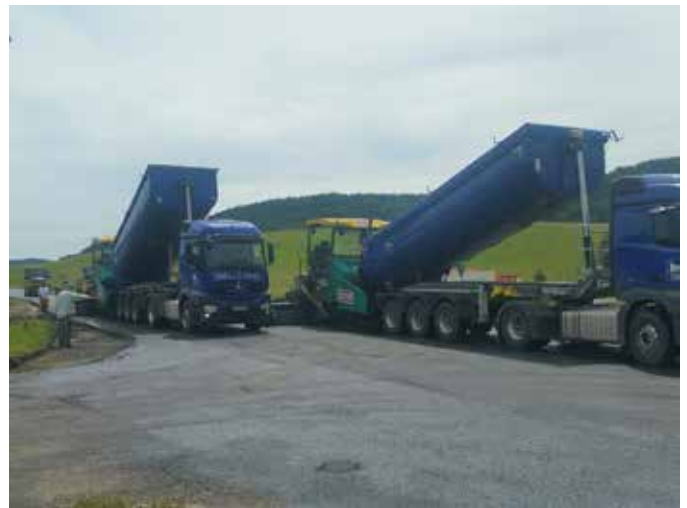
Staatsstraßensanierung und Linksabbiegespur Woffendorf
