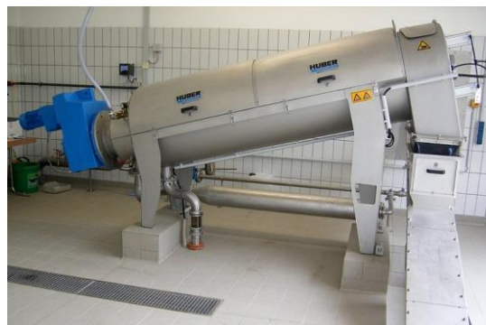
Abbildung 56: Beispiele einer Schneckenpresse zur stationären Klärschlammmentwässerung der Hersteller IEA (links) und Huber (rechts) (Quelle: IEA Derflinger und Huber SE)
