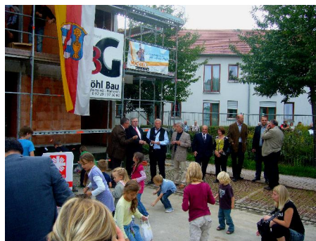
Richtfest für den Erweiterungsbau am 24.09.2010
