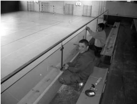
Neues Tribüengeländer in der Kordigasthalle
